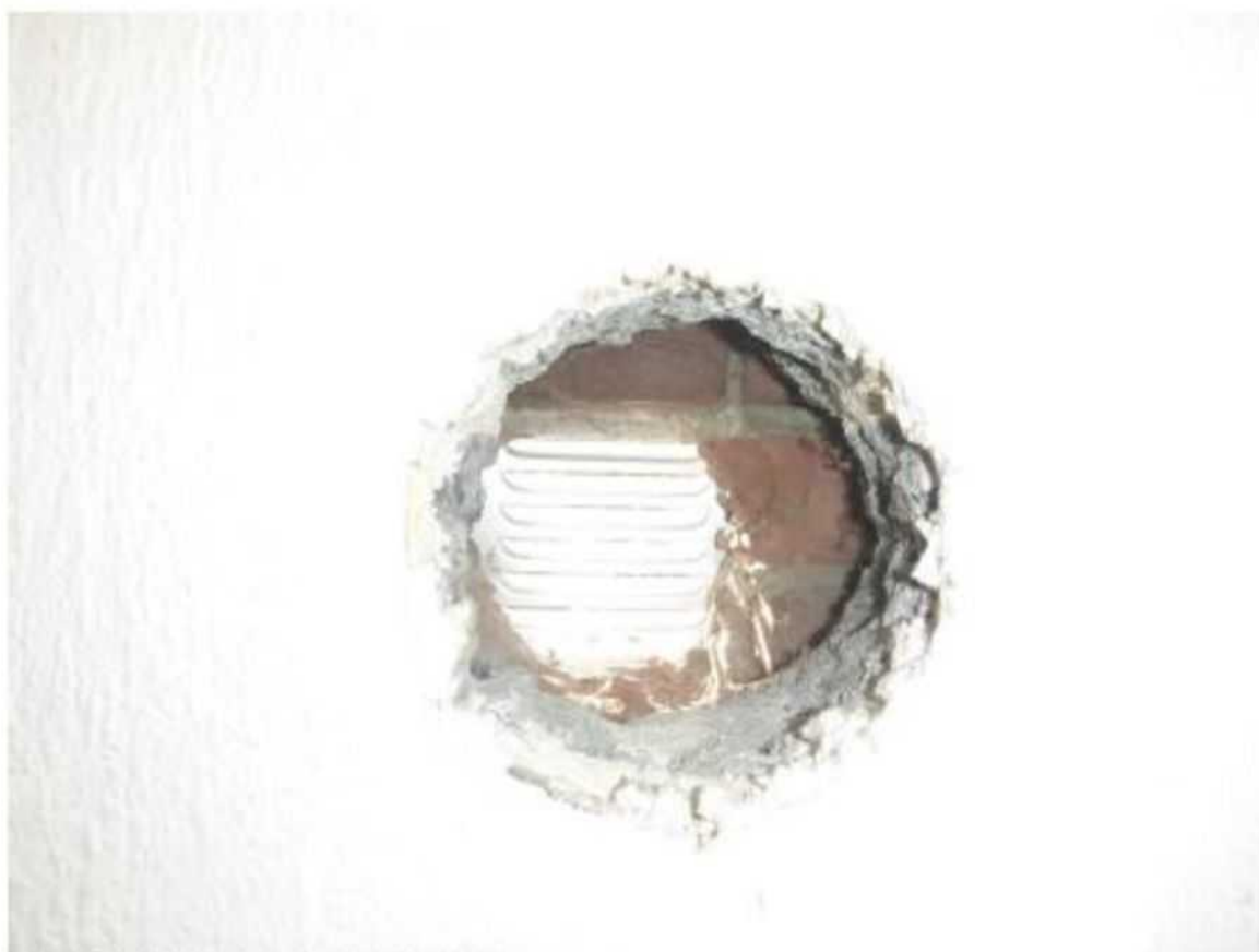
Doorvoeren niet asbestverdacht
